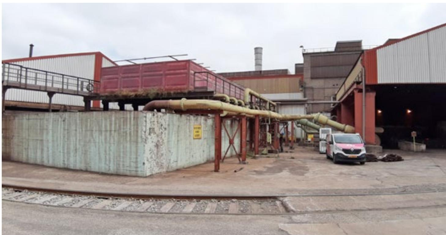
Industeam Luxembourg s'est vu confier un chantier de remplacement de l'ensemble des tours réfrigérantes (4) sur le circuit QST – refroidissement des eaux de traitement thermique des poutrelles en sortie de laminage.
